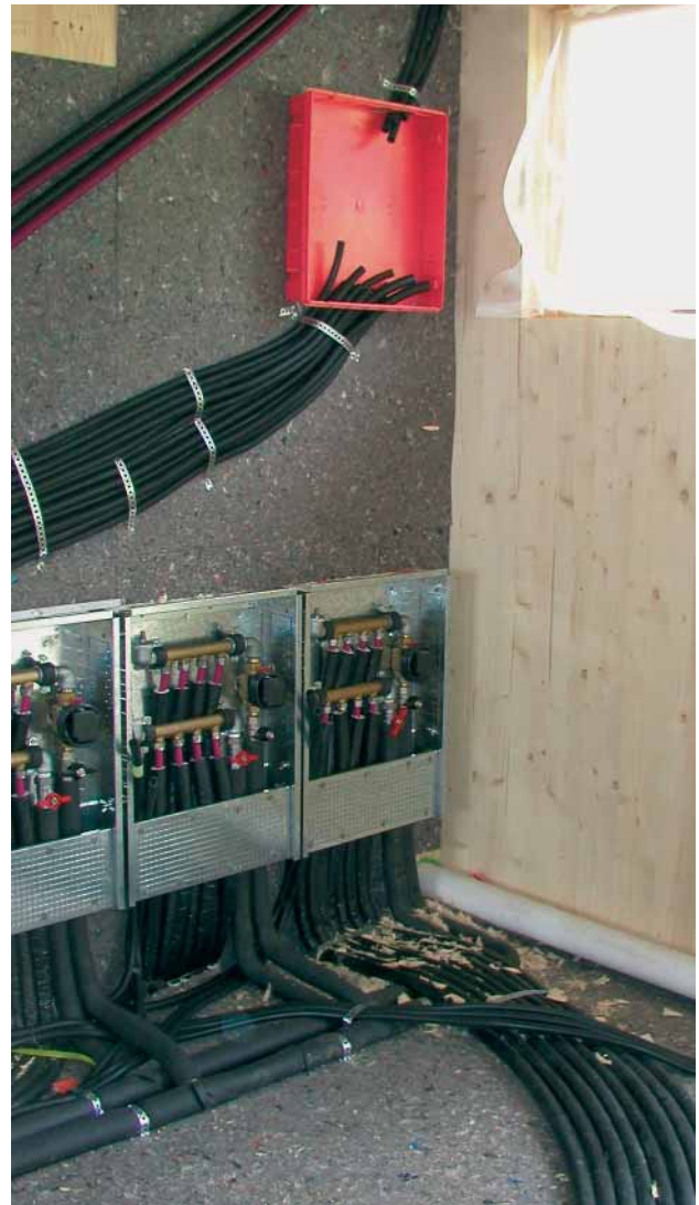
Foto a dx: montaggio di un sistema elettrico collocato fra la parete a pannelli KLH e la parete in cartogesso, così da isolare staticamente il sistema
